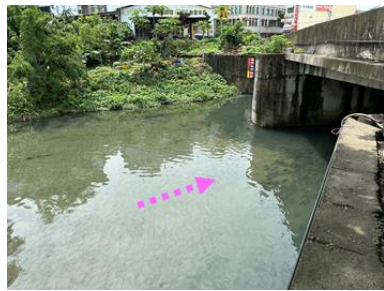
排水路現況(大智路側)
