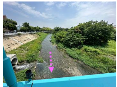
排水路現況(南門橋上游)
