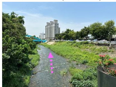
排水路現況(喬城路下游)
