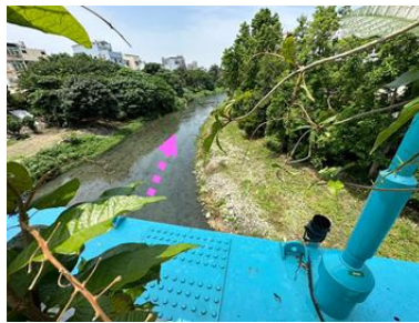
排水路現況(南門橋下游)
