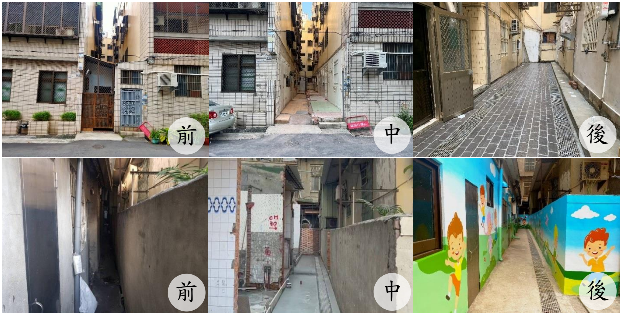
房屋後巷污水用戶接管環境改善
