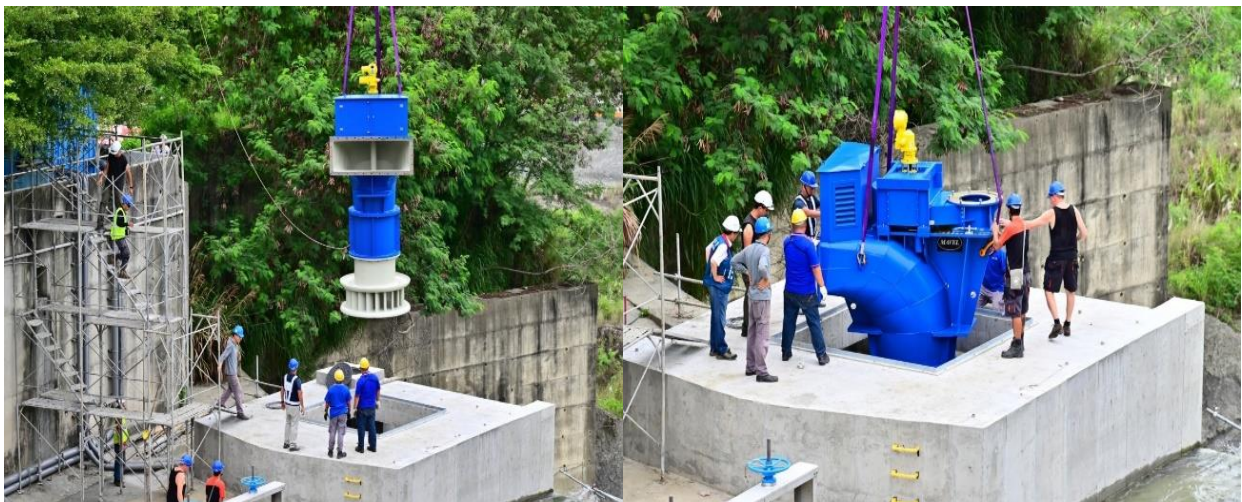
水輪機設備安裝
