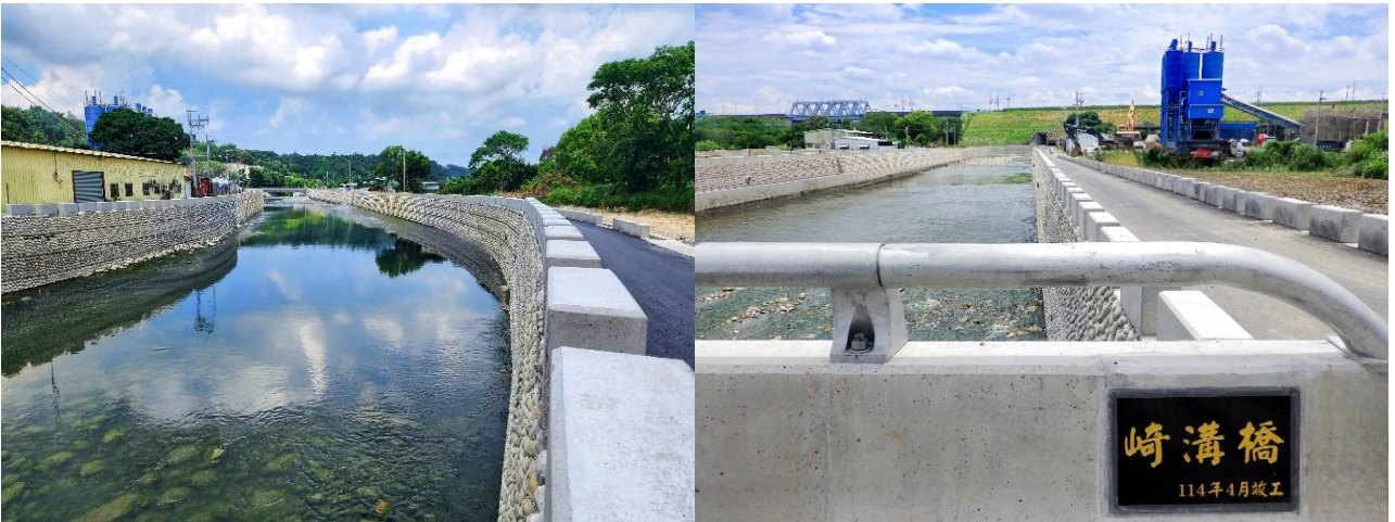
軟埤仔溪整治完工
