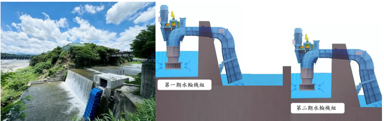
小水力第一期完工照及二期計畫配置
