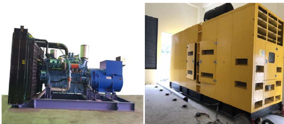
新設發電機體積小且加裝防音外箱降低運轉時噪音
