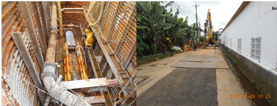
九渠溝滯洪池輸水工程
