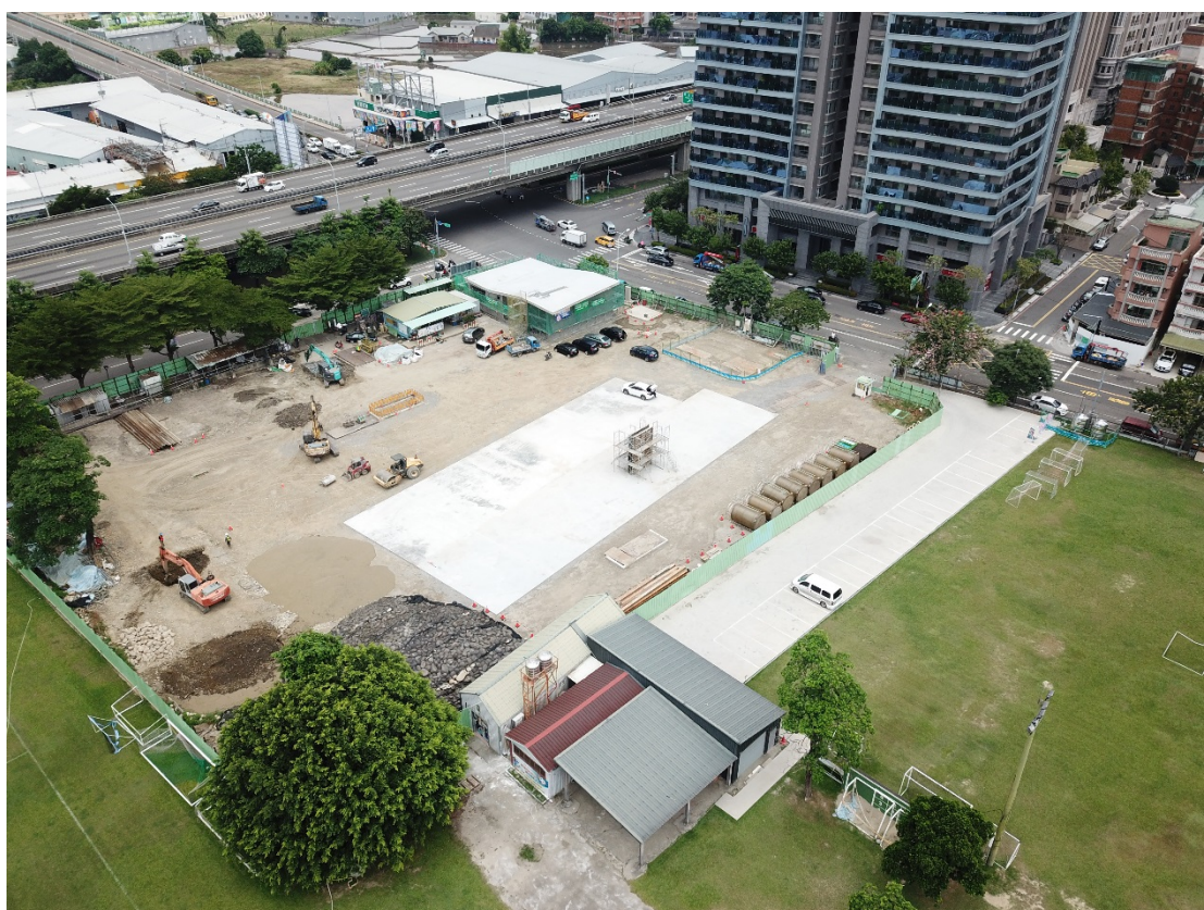
朝馬礫間處理廠鋪面工程
