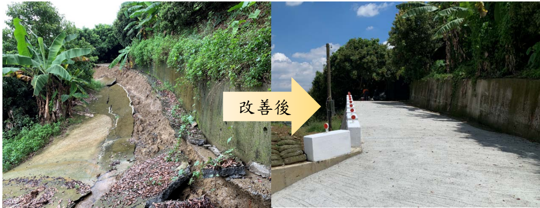
大里區健民里佑福宮上方產業道路改善完成
