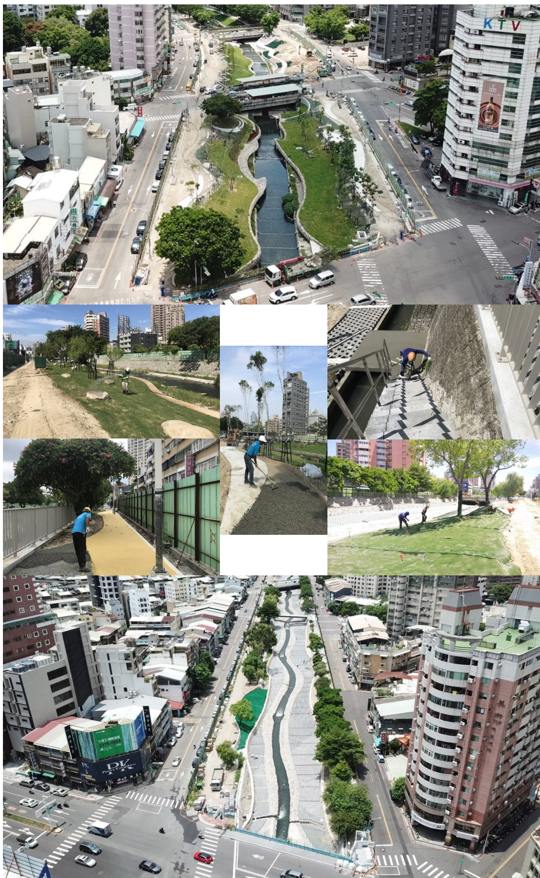
柳川河道施工現況
