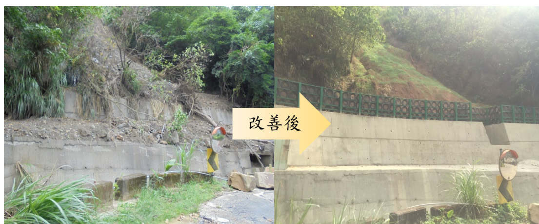
改善太平區牛角坑溝邊坡崩塌復建工程
