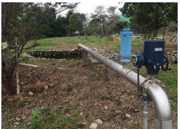
現況砌石水道放流管。
