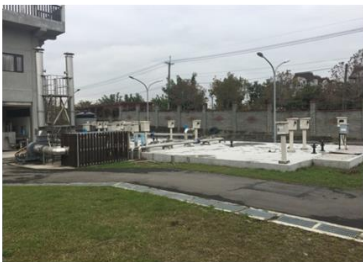
黎明水資源回收中心既有揚水井設施
