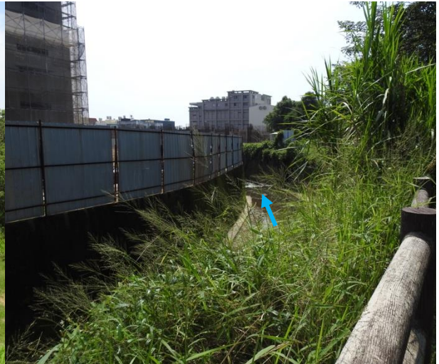
2. 工程預定位置西端往西拍攝。箭頭方向為水流方向，圖中旱溝左岸為乙種工業區，左右岸護岸均已水泥化。
