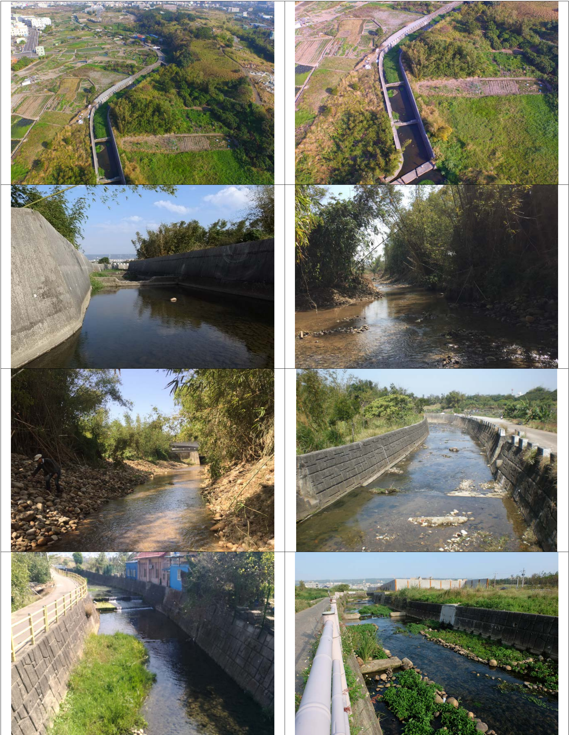
附件 水域棲地、水岸及護坡照片
