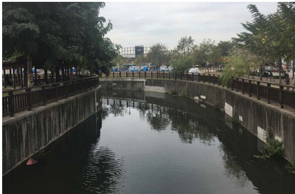
附件:水域棲地、水岸及護坡照片
