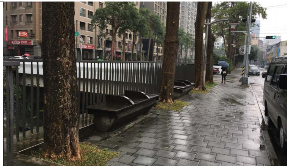
附件：水域棲地、水岸及護坡照片
