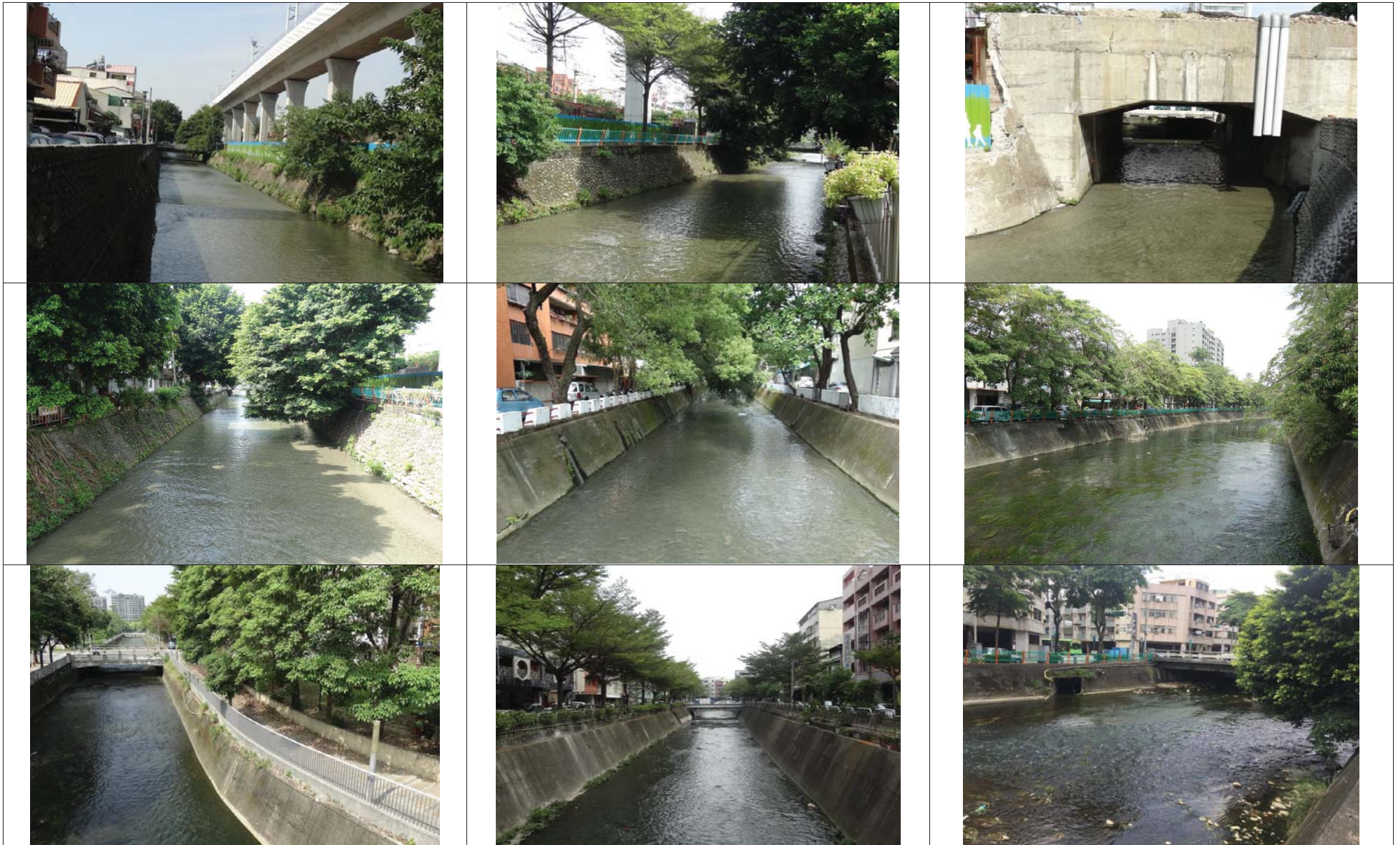
附件 水域棲地、水岸及護坡照片
