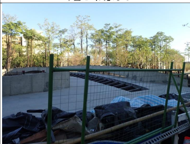
計畫區環境現況-工程現況
