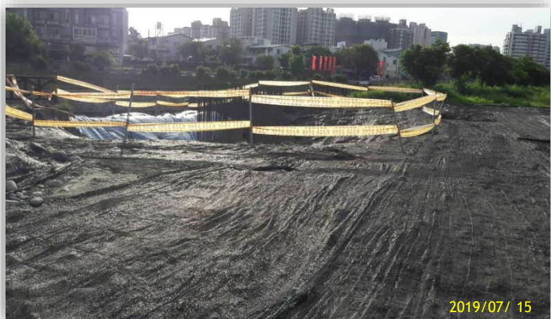
土方堆置覆蓋防塵網
