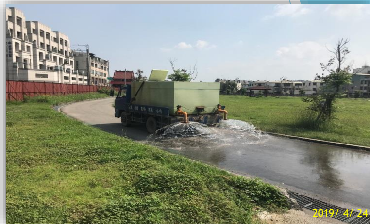
工區內灑水抑制揚塵
