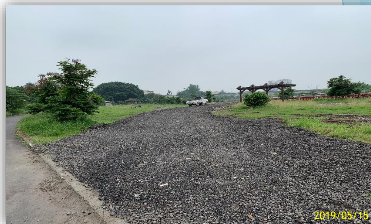
施工便道鋪設回收瀝青
