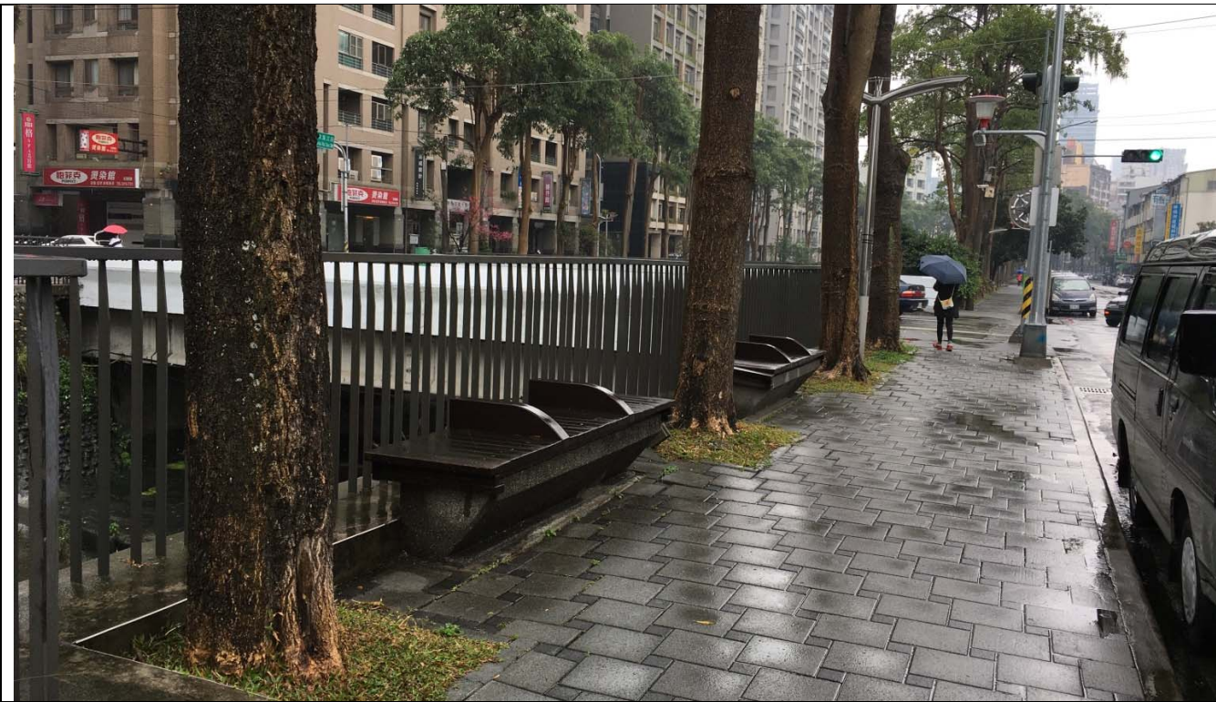
附件：水域棲地、水岸及護坡照片
