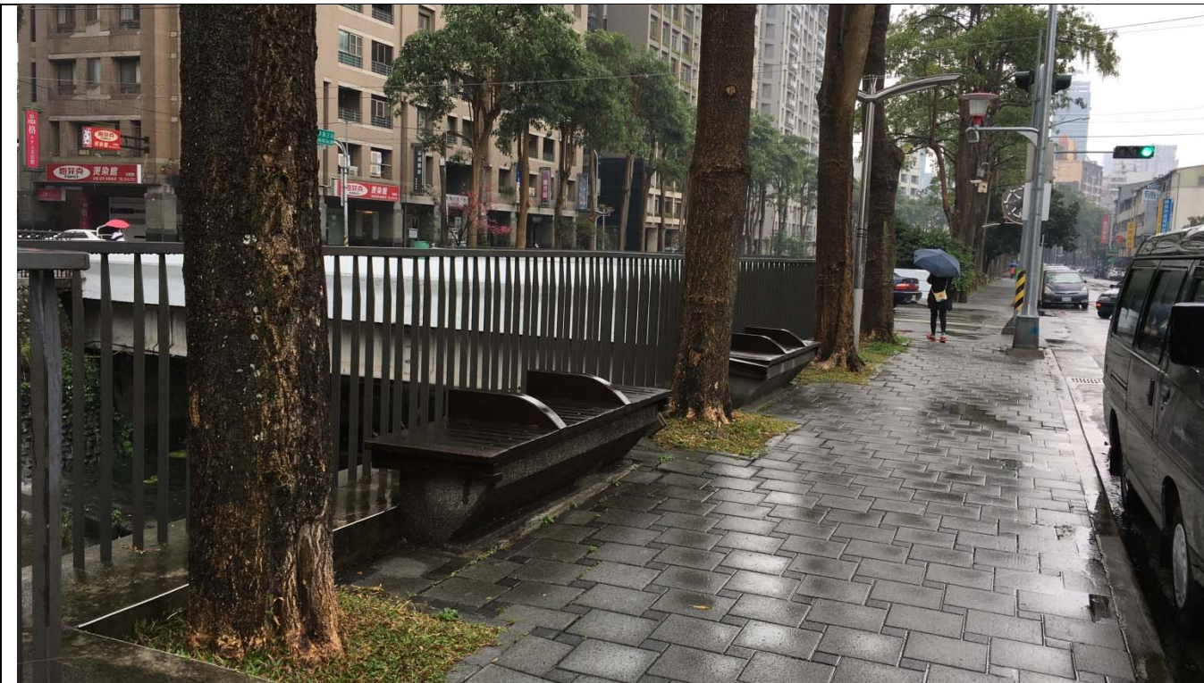
附件：水域棲地、水岸及護坡照片
