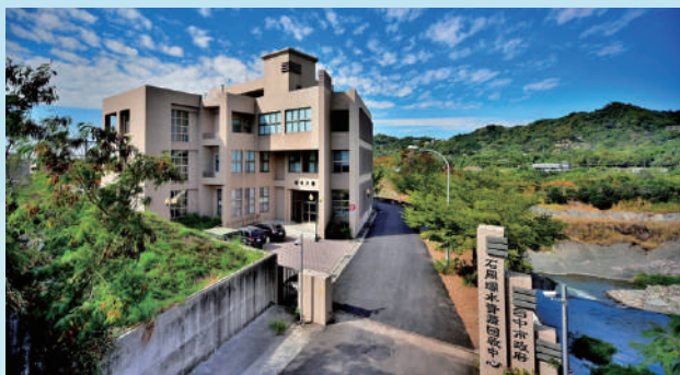
石岡壩水源特定區水資源回收中心
