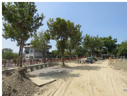
滯洪池周邊既有樹木
