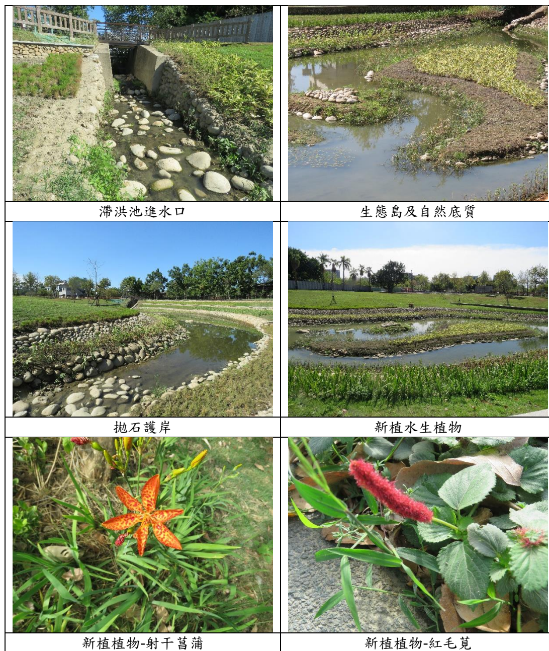
照片 3-8、施工生態友善措施執行情形
