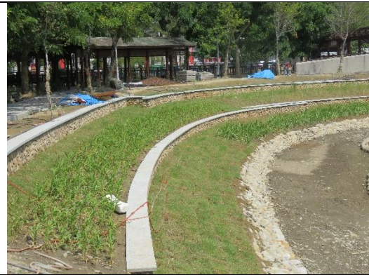
滯洪池邊坡緩坡化
