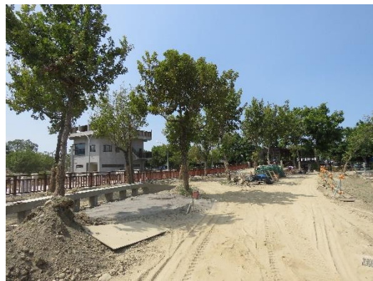
滯洪池周邊既有樹木
