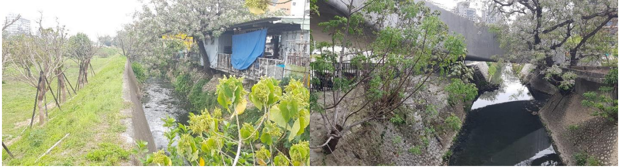
圖 16 惠來溪河南路二段至經貿路段現況照片
