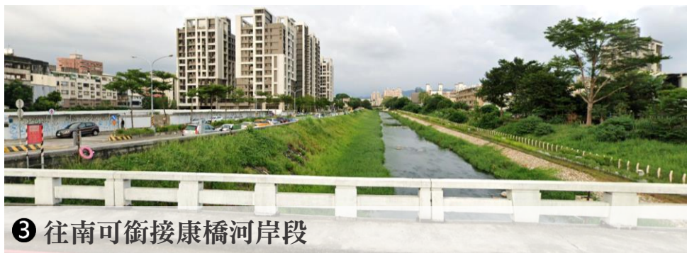
② 中段現況腹地廣大
