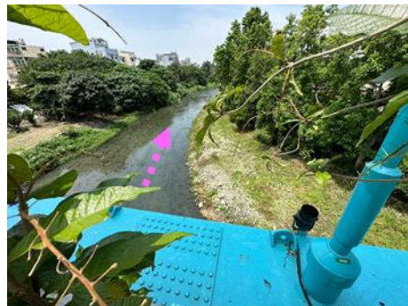
排水路現況(南門橋下游)
