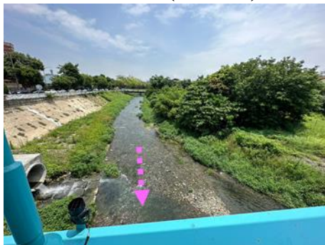
排水路現況(南門橋上游)
