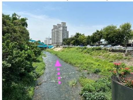
排水路現況(喬城路下游)
