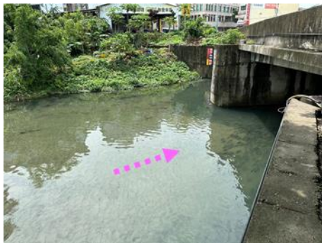
排水路現況(大智路側)
